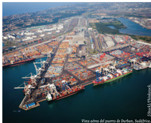
Vista aérea del puerto de Durban, Sudáfrica.
