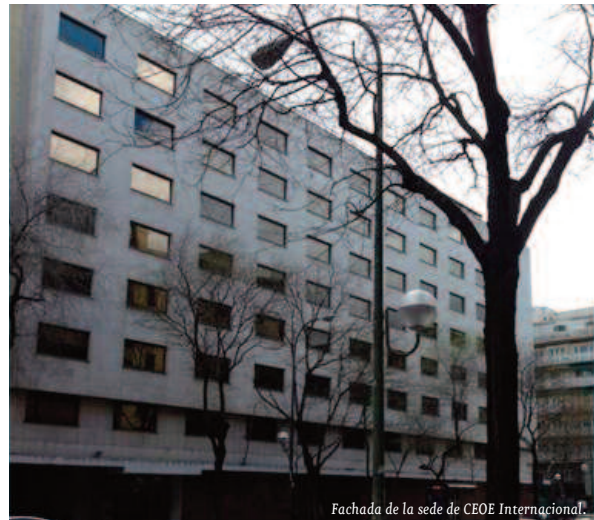
Fachada de la sede de CEOE Internacional.
