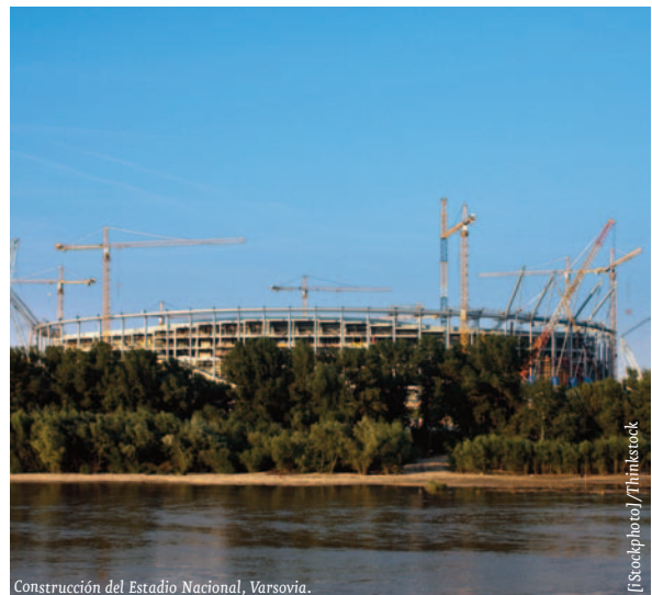
Construcción del Estadio Nacional, Varsovia.
