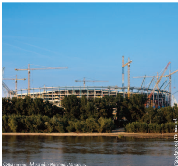
Construcción del Estadio Nacional, Varsovia.
