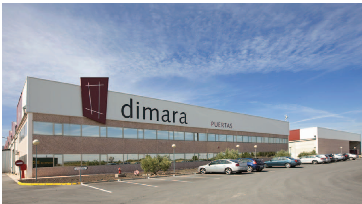
Fachada de Puertas Dimara.
