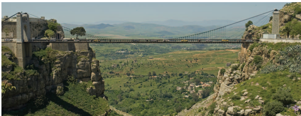
Puente de Sidi M'Cid en Constantina, Argelia.
