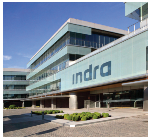
Puerta principal sede central Indra.
